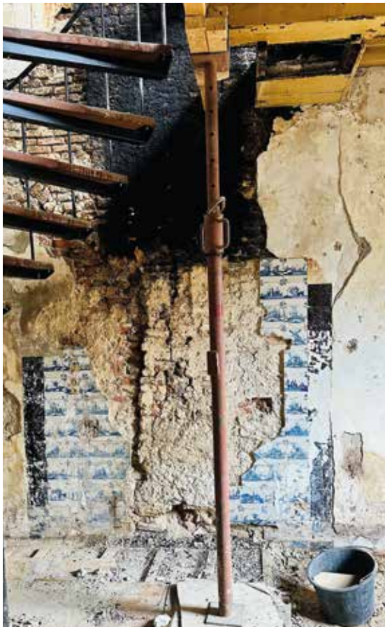
Resten van een 17 e -eeuwse keuken- schouw achter een voorzetwand (Bloemendalsestraat).
