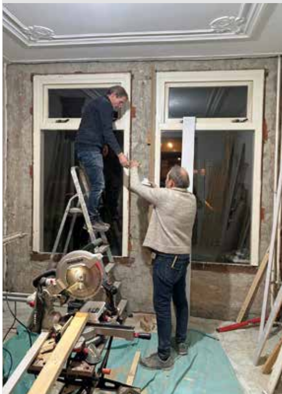
De voorgevel van binnenuit geïsoleerd met isolatiemateriaal rond de ramen.
